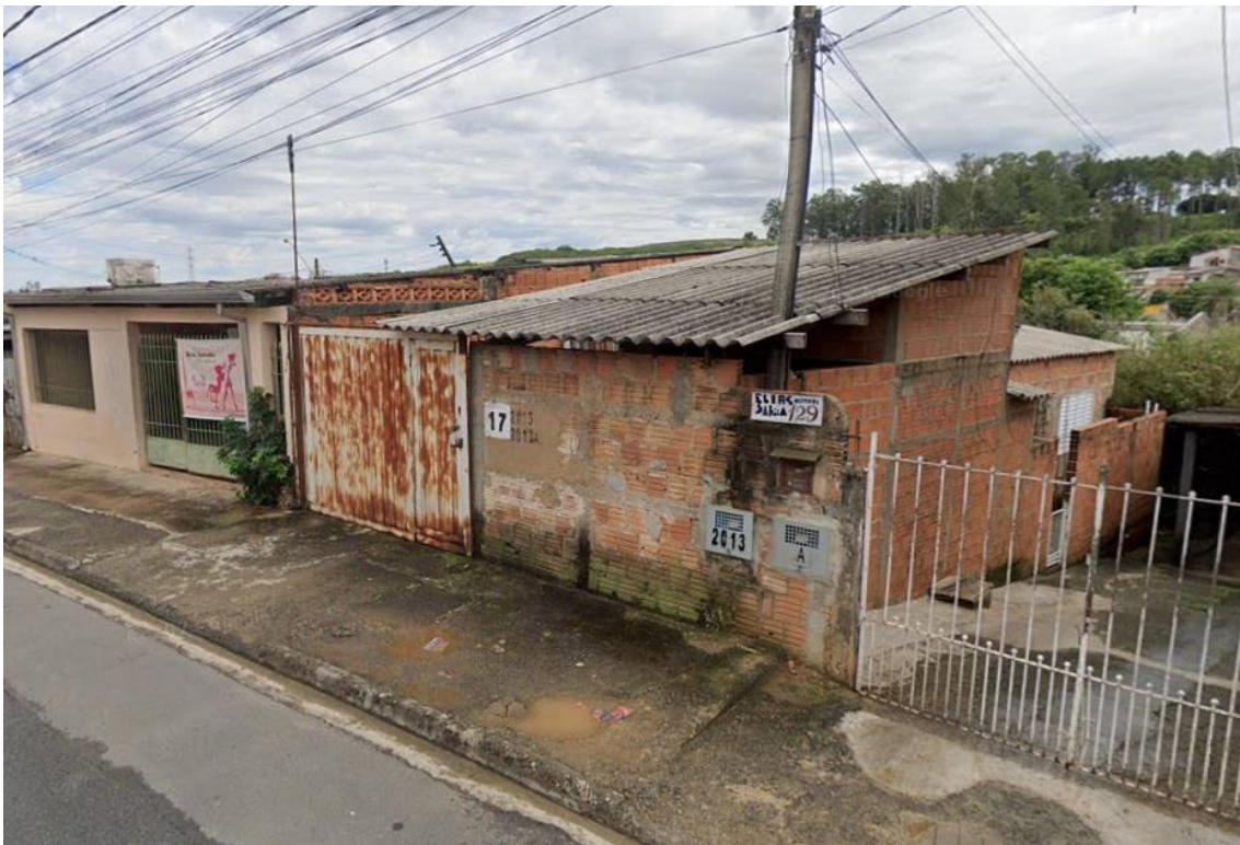
Figura 8. Ocupação irregular – Rua Elias de Oliveira Sabóia.
