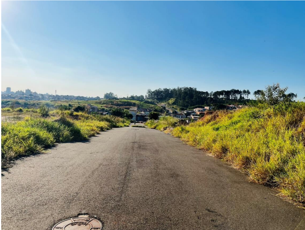
Figura 12. Vista da Rua Serra da Esperança.
