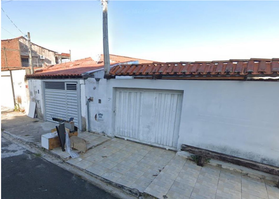
Figura 19. Residência unifamiliar – Rua Capixaba.
