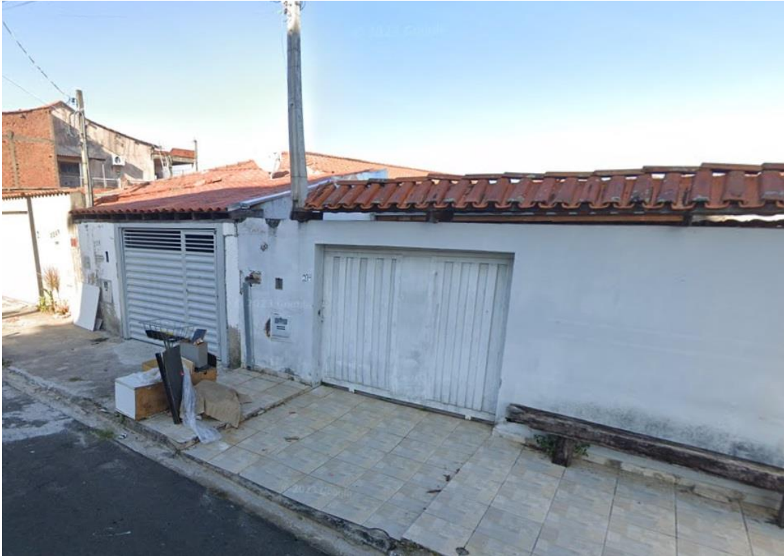
Figura 9. Residência unifamiliar – Rua Capixaba.
