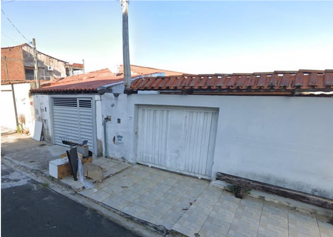
Figura 9. Residência unifamiliar – Rua Capixaba.
