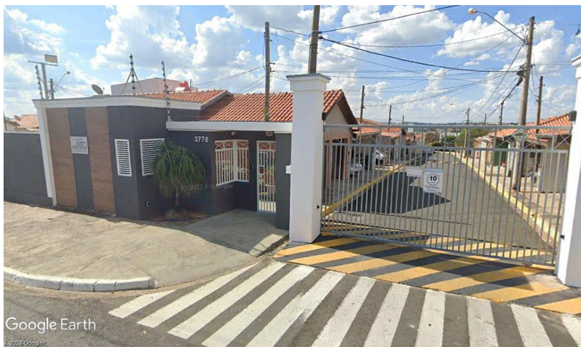
Figura 10. Residencial multifamiliar horizontal encontrada na AII.
