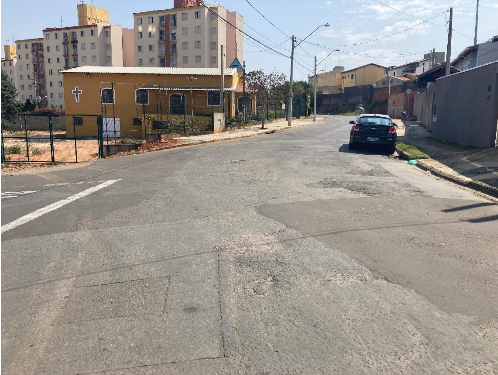
Figura 25. Vista da Rua Agnaldo Macedo.
