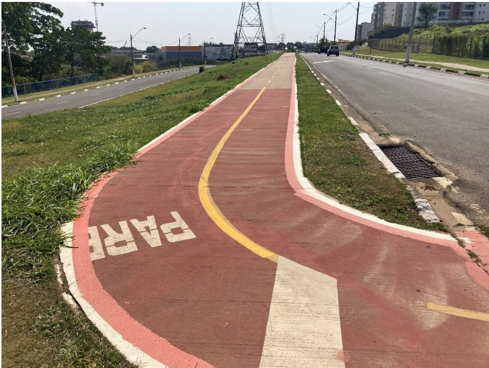
Figura 16. Vista ciclovia da Avenida Baden Powell.
