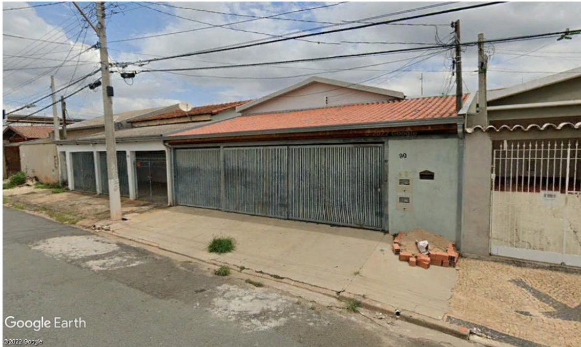
Figura 28. Residências unifamiliares – Rua Cacique Piquerobi.
