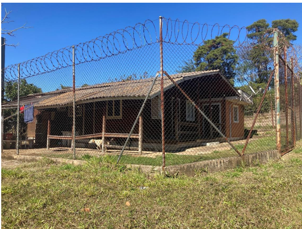
Figura 05. Vista da residência unifamiliar antes da demolição executada.
