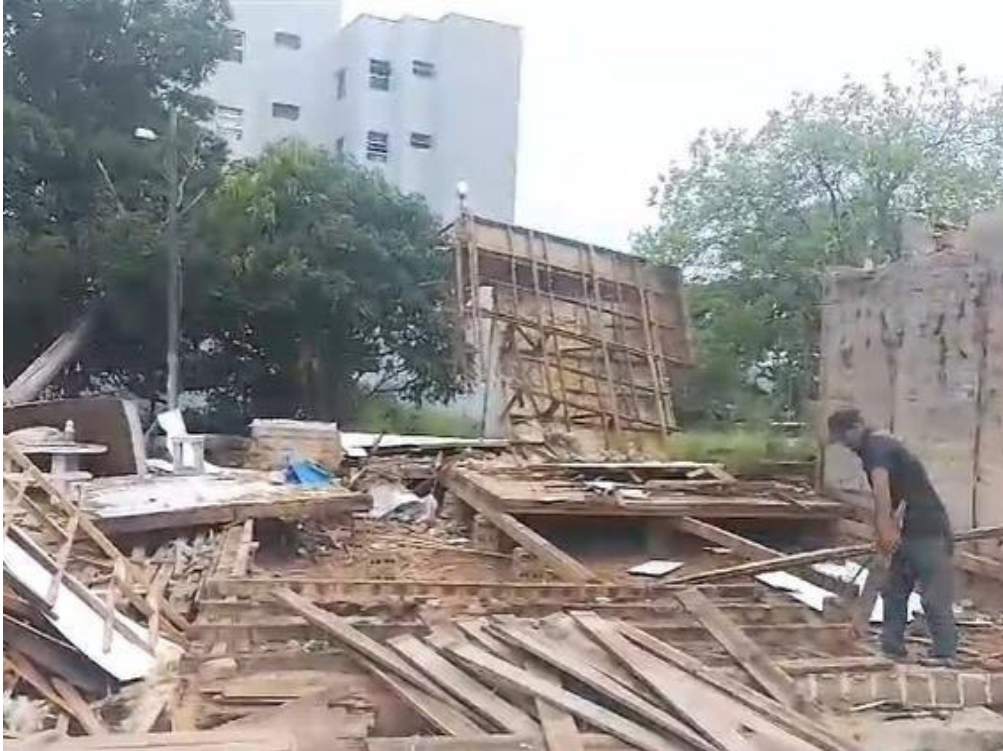
Figura 06. Vista da obra de demolição em andamento.
