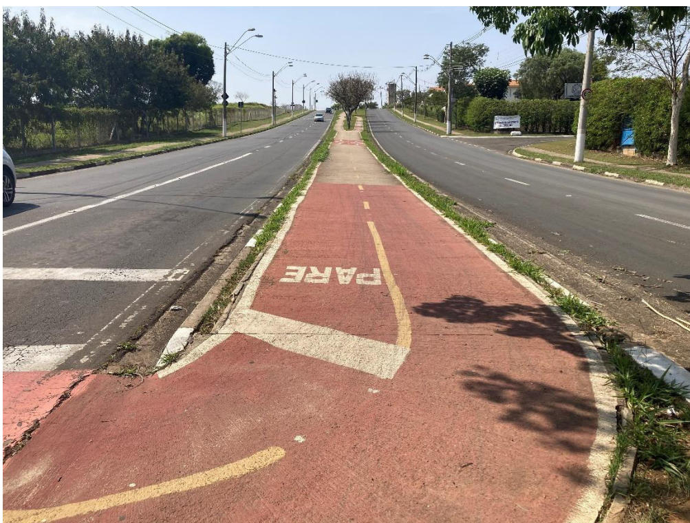
Figura 51. Vista da ciclofaixa da Rua Lux Aeterna.
