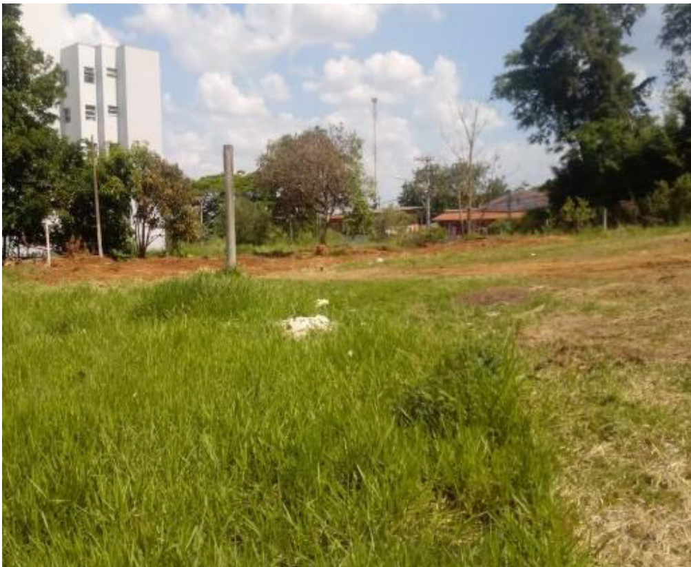
Figura 07. Vista da obra de demolição finalizada.
