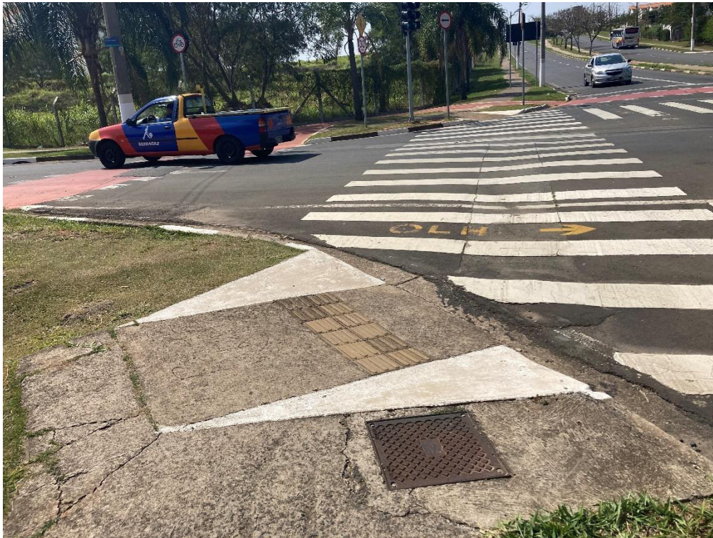
Figura 48. Vista de faixa de pedestre e local para acessibilidade na Avenida Baden Powell.
