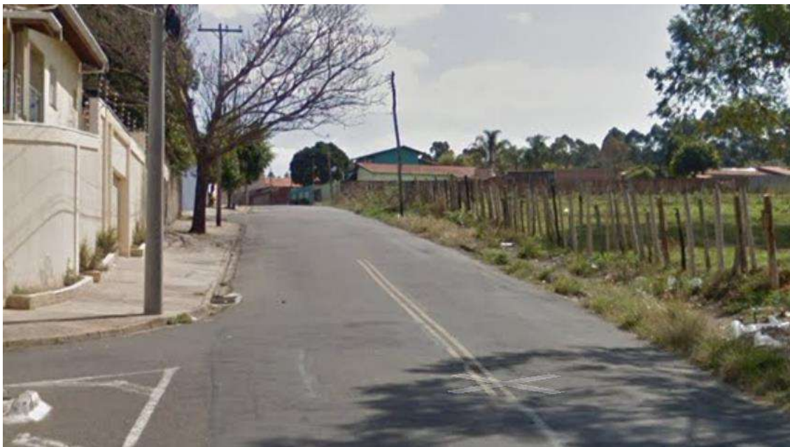
Figura 24. Vista geral da Rua Gertrúdes Mouro Rossin.
