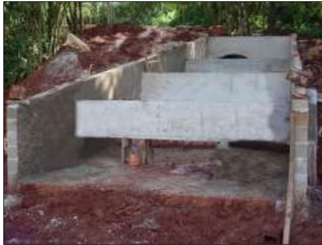
Figura 7 - Execução de muro de ala
