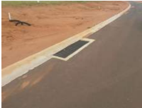
Figura 3 - Acabamento de guia com abertura para boca de lobo
