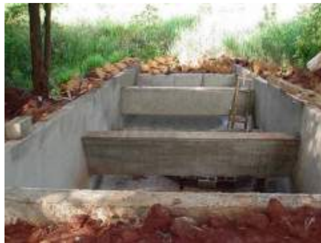
Figura 8 - Execução de muro de ala
