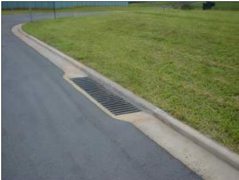
Figura 5. Acabamento da boca de lobo
