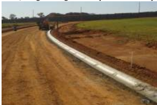
Figura 2 - Execução de guia e sarjeta extrusada
