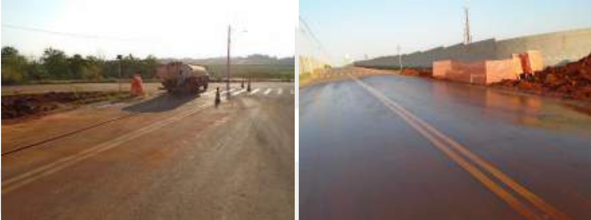
Figura 16. Exemplo de lavagem das vias de entorno, evitando que sedimentos da obra entrem na rede de drenagem urbana.
