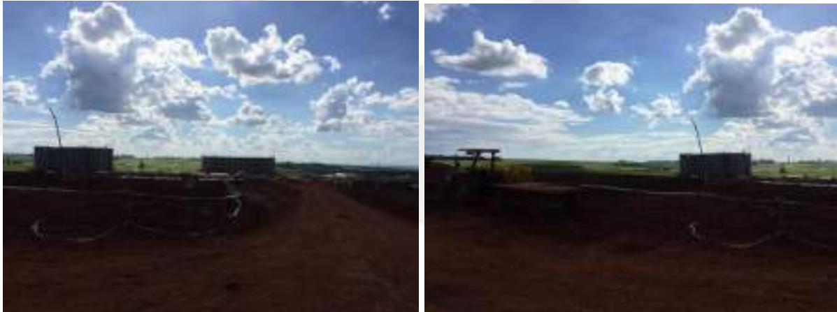
Figura 18. Exemplos sinalização e isolamento de área.
