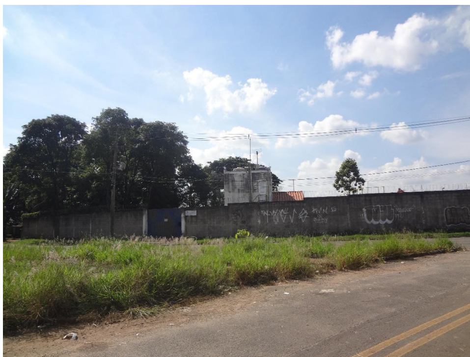
Foto 7 - Vista da Estação de Tratamento de Esgoto Mirassol (ETE) com tecnologia adotada de Lodos Ativados por Aeração Prolongada em fluxo contínuo e Desinfecção.
