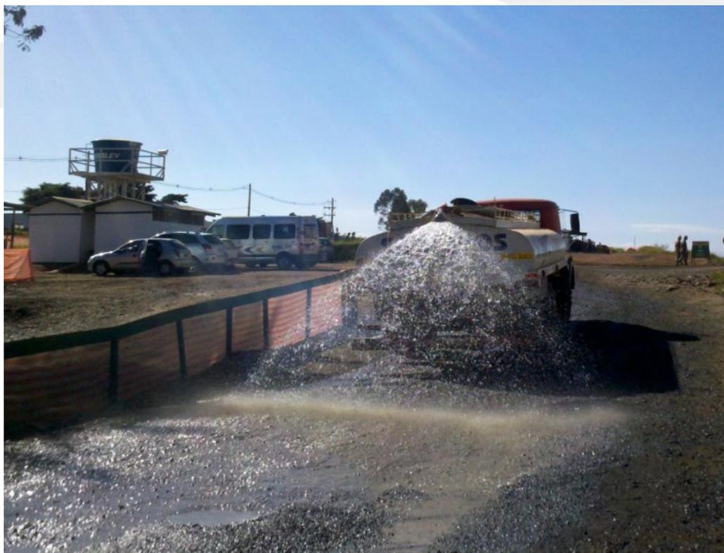
**Figura 16. Exemplo de umidificação de via da obra.**
