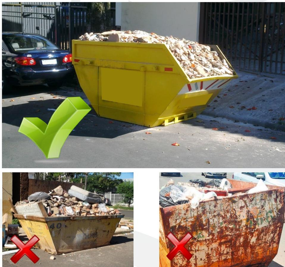
Figura 20. Modelo de acondicionamento de resíduos em caçambas.
