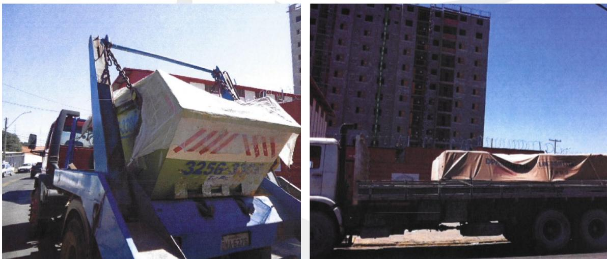
Figura 17. Exemplos de “lonamento” em caçamba de entulho e caminhão.
